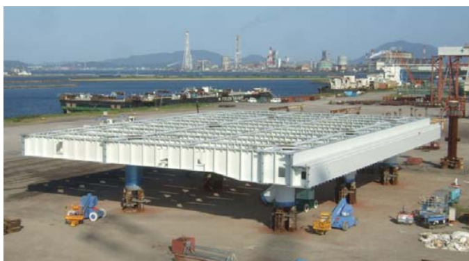
UIT 処理された羽田 D 滑走路ジャケット
