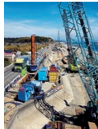
高知海岸での施工状況
