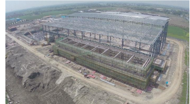
[ 建設が進む平胡特殊鋼現地(H27.4撮影) ]
