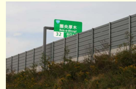
[用途例: 遮音壁]
