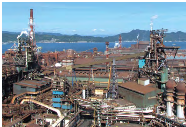
●呉製鉄所(広島県呉市)／高炉全景
