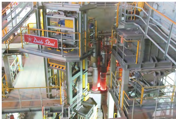
●呉製鉄所(広島県呉市)／LF設備
