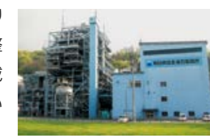
釜石製鉄所の発電設備
