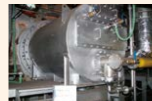
対になった2つのバーナーで吸熱・加熱を交互に行う加熱炉。従来に比べ1/4の省エネルギーを実現
