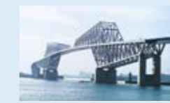
東京ゲートブリッジ
