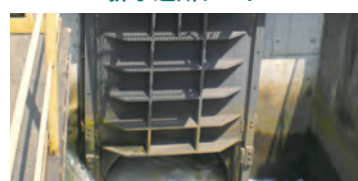
排水遮断ゲート
