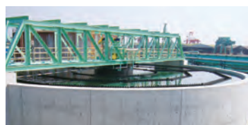
雨水排水処理設備
