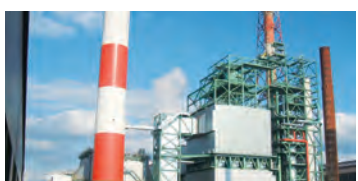
活性コークス式乾式脱硫脱硝設備
