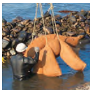
ビバリー®ユニットの施工
