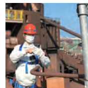
自営無線網基地局の電波調査状況
