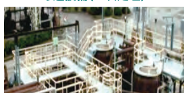
ろ過設備(二次処理)
