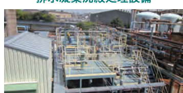
排水凝集沈殿処理設備
