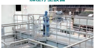
加圧浮上設備
