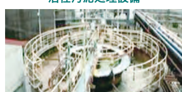
活性汚泥処理設備
