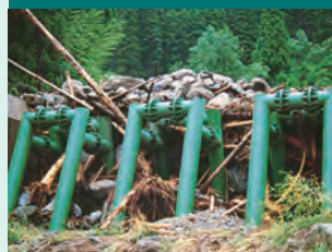
土石流中の巨礫・流木捕捉
