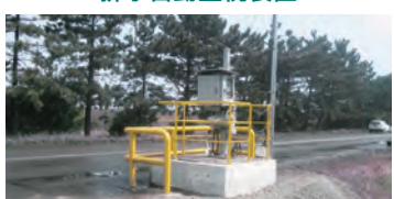
排水自動監視装置
