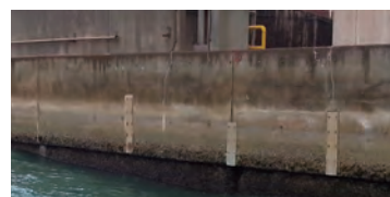
護岸損傷部の補修
