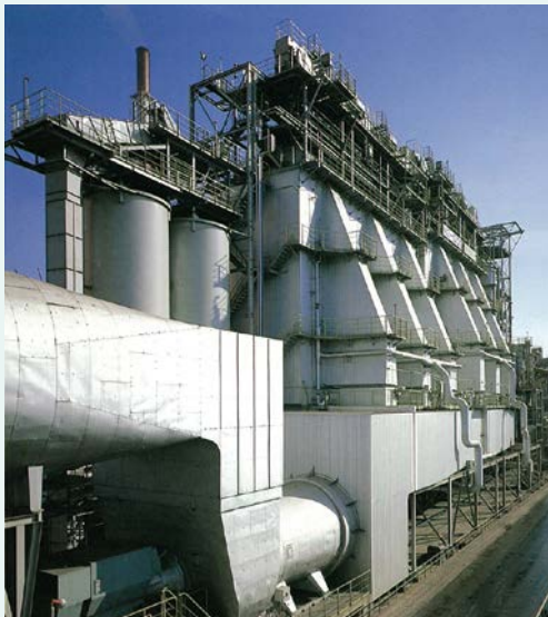
名古屋製鉄所・乾式脱硫脱硝設備
