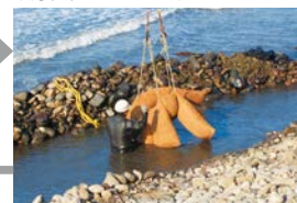
鉄鋼スラグから溶出した鉄分は、腐植物質と混ざることによって、酸化せず植物に吸収されやすくなります。
