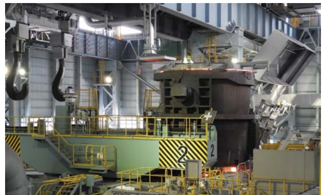
新鋭連続鋳造設備（八幡製鉄所）
