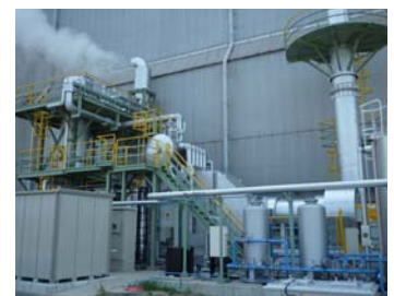
廃熱回収ボイラー
