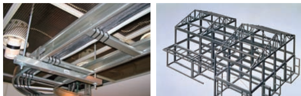
ケーブルラック
