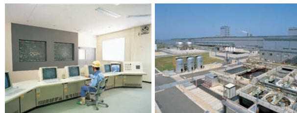
ユーティリティー監視センター 水処理設備
