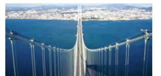
明石海峡大橋
