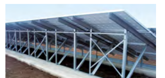
ソーラーパネルの設置用架台
