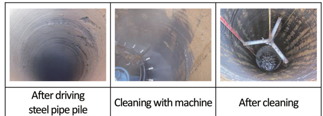
写真6 洗浄前後の鋼管内部の様子 Before and after cleaning inside steel pipe pile
