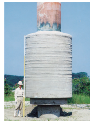
写真1 先端根固め部 5) Expanded foot protection section 5)
