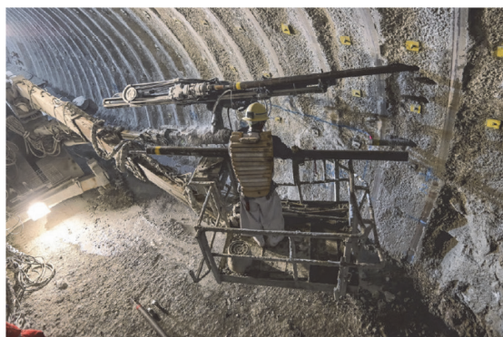
図5 ハイテン鋼管試験施工状況 2) Picture of AGF method with high-tension pipe 2)
