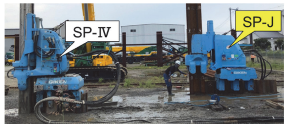
図 9 施工試験の状況 Status of penetration tests
