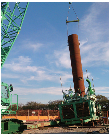
写真 2 斜杭施工 Batter-piling
