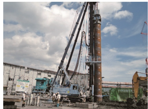
写真1 中掘り杭工法の施工状況 Inner-excavation steel piling
