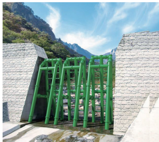
図4 鋼製スリットダム AB 型 Steel slit dam (AB-type)
