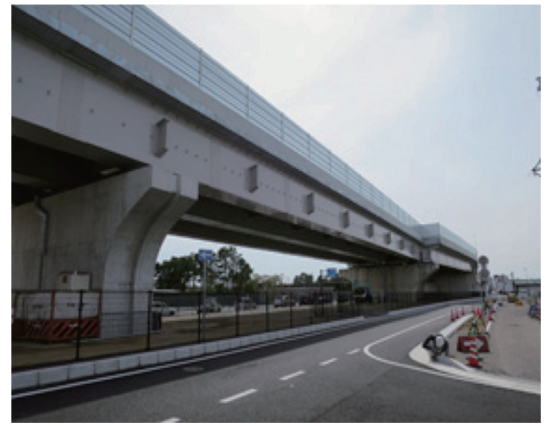
図6 CORSPACE® の橋梁適用例 (東播磨南北道路) 13) Application example of CORSPACE™ (Higashiharimanamboku Road) 13)
