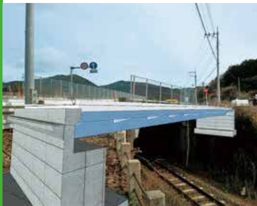
鏡山跨線橋(福岡県) 写真提供: (株)横河ブリッジ
