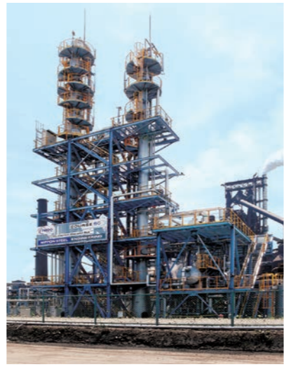
Super COURSE50の開発が進められている試験炉とCO 2 分離・回収装置(日本製鉄 東日本製鉄所君津地区構内) 出典元: NEDO 製鉄プロセスにおける水素活用プロジェクト
