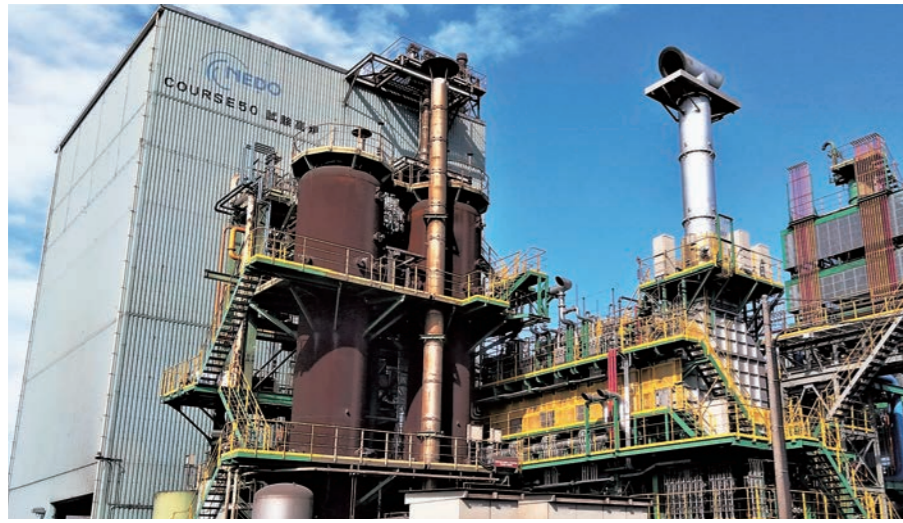
Super COURSE50の開発が進められている試験炉とCO 2 分離・回収装置(日本製鉄 東日本製鉄所君津地区構内) 出典元: NEDO 製鉄プロセスにおける水素活用プロジェクト
